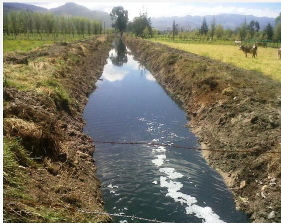
FOTO LUEGO DE INTERVENCIÓN JUNTO A LA VIA VALLADO CAIMAN
