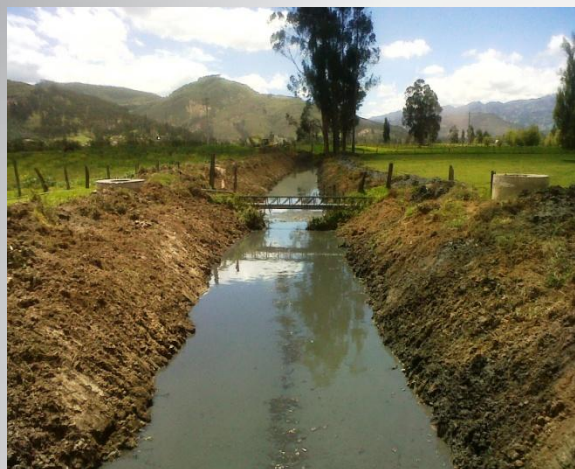
FOTO FINAL TRAMO HACIA COMPUERTAS NORTE.
