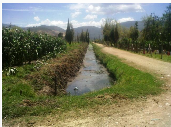
FOTO LUEGO DE INTERVENCIÓN VISTO DESDE PTE HACIA ESCUELA SIATAME
