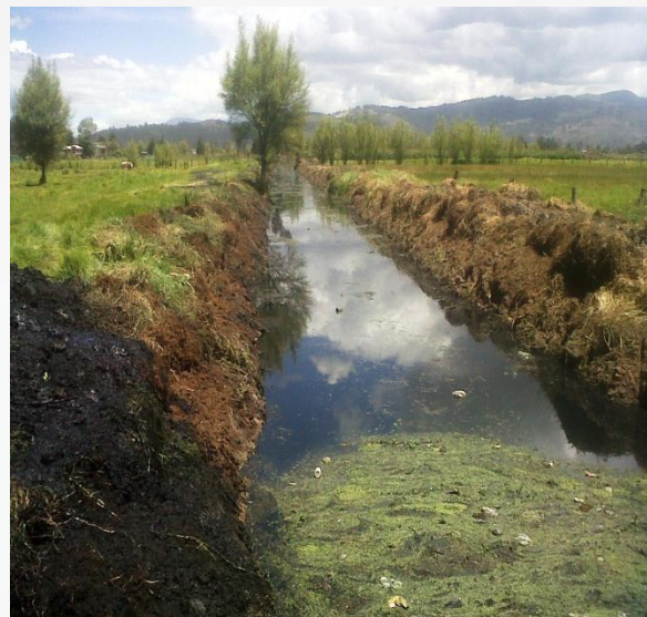
FOTO FINAL INTERVENCIÓN VISTA HACIA EL SUR
