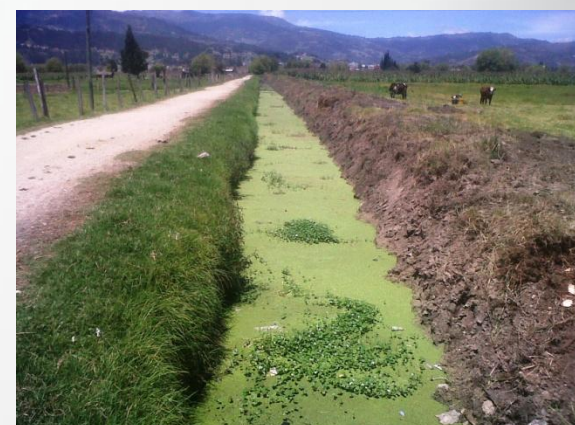
FOTO FINAL DE INTERVENCIÓN PUENTE JUANITO DESPEJE DE TUBERIAS.
