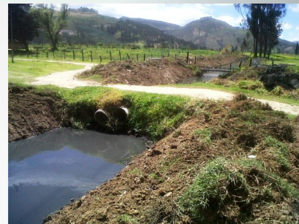
FOTO FINAL TRAMO PUENTE JUANITO DESPEJE DE TUBERIAS
