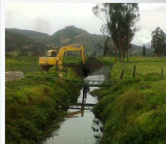
FOTO INICIO DIA 14 DE JUNIO 2013, VISTA HACIA COMPUERTAS NORTE.
