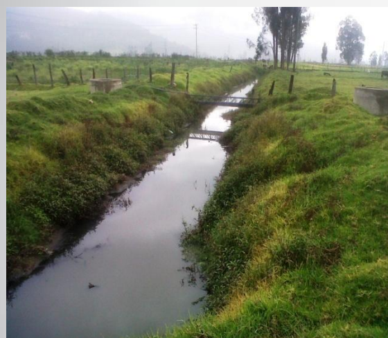
FOTO ANTES DIA 12 DE JUNIO 2013, VISTA HACIA COMPUERTAS NORTE.
