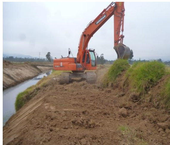
FOTO AVANCE CALLE 1 SUR HACIA LA CALLE 11 SUR.
