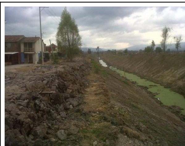
FOTO FINAL TRABAJOS A LA ALTURA DE VILLA DEL RIO
