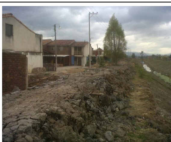
FOTO FINAL TRABAJOS A LA ALTURA DE VILLA DEL RIO
