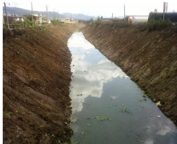
FOTO FINAL TRABAJOS SECTOR CENTRO DE CONVIVENCIA
