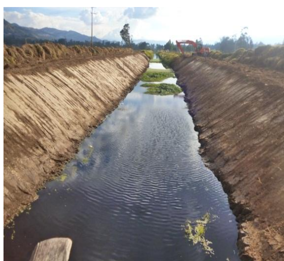
FOTO AVANCE CALLE 1 SUR HACIA LA CALLE 11 SUR.
