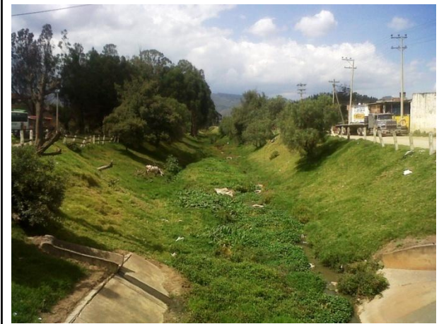
FOTO PREVIO A TRABAJOS CALLE 11 HACIA LA LINEA FERREA
