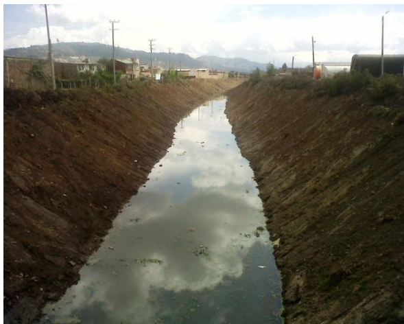
FOTO FINAL TRABAJOS SECTOR CENTRO DE CONVIVENCIA
